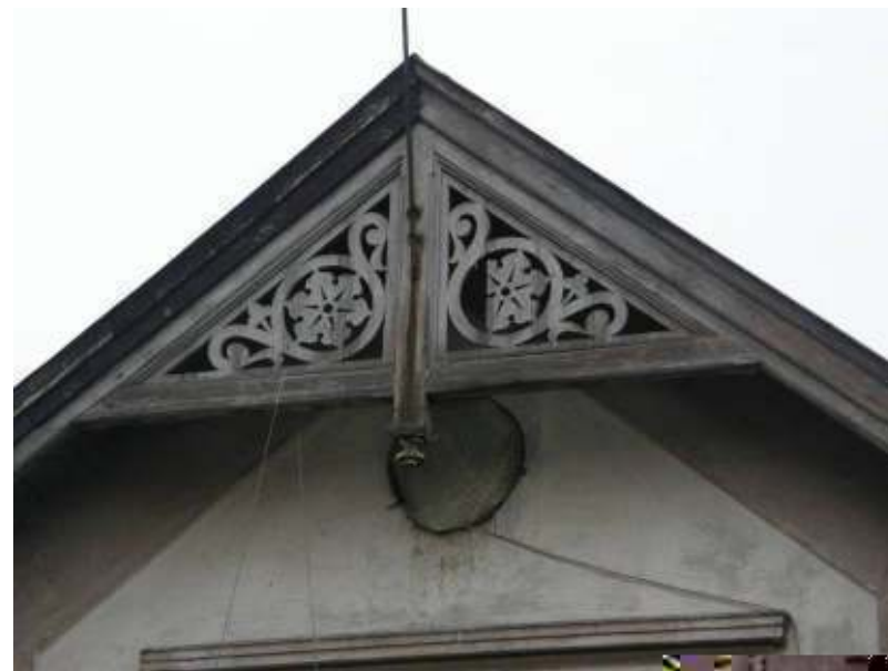
Fot. Stolarka w narożach dachu
