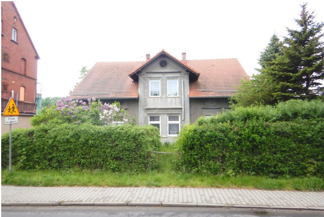
Ogólny widok budynku
