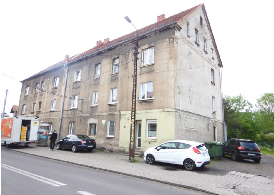
Ogólny widok budynku
